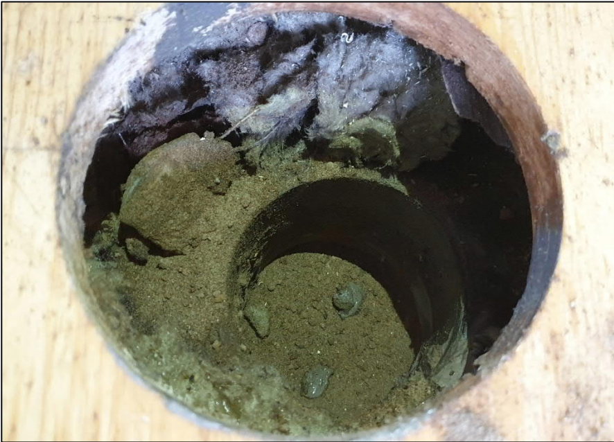
Figur 11. Golvkonstruktion av trägolv, luftspalt, mineralull, betongplatta och sand/gruslager i provpunkt för porluftsprovtagning, provpunkt NC2008.
